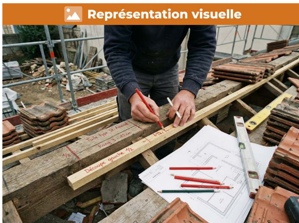
Un bon calepinage évite les erreurs lors de la pose de nouvelles tuiles
